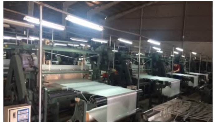
Mô hình sử dụng bóng đèn LED thay thế bóng đèn huỳnh quang tại Công ty TNHH Xe tơ - Dệt lụa Hà Bảo
