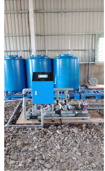
Bộ điều khiển tưới và pha phân bón tự động theo pH/EC qua internet
