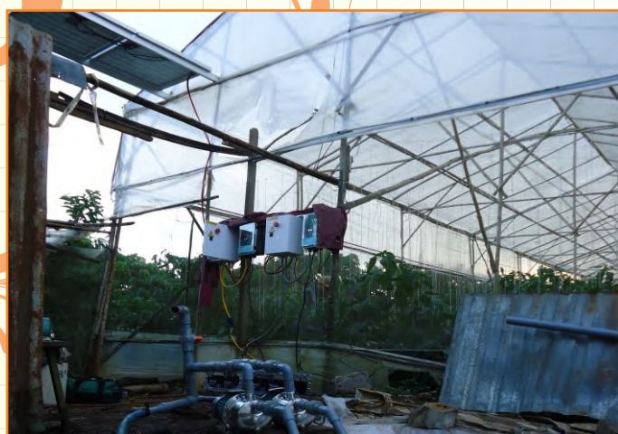
Lắp đặt hệ thống tưới nhỏ giọt bằng năng lượng mặt trời tại xã Tân Hội, huyện Đức Trọng
