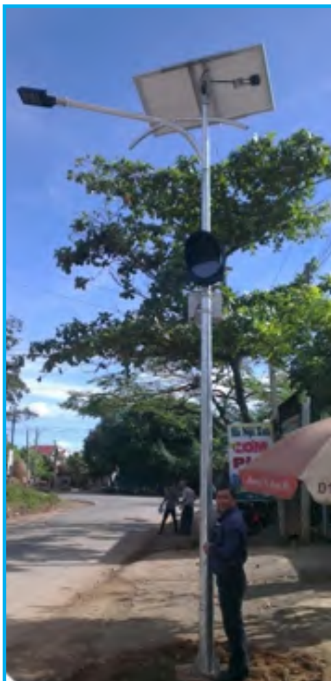
Trụ đèn cảnh báo giao thông kết hợp đèn chiếu sáng
