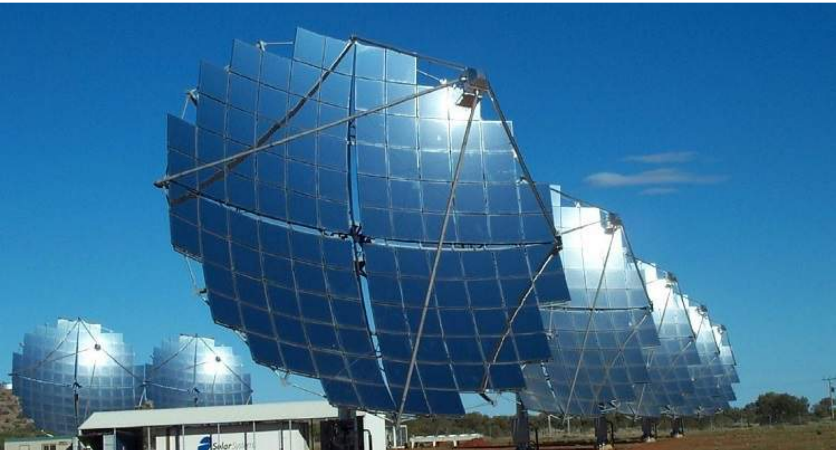
Công nghệ CSP là một trong hai công nghệ hiện đại hiện nay giúp tạo ra nguồn điện năng bằng cách chuyển gián tiếp từ quang năng sang nhiệt năng rồi chuyển từ nhiệt năng sang điện năng. Ảnh: Solarfeeds.
