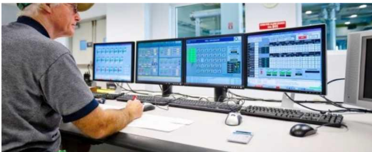
Hình 4. Theo dõi vận hành nhà máy nước bằng phần mềm tự động hóa
