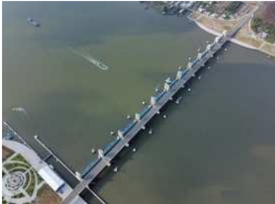
Toàn cảnh cống Cái Lớn nhìn từ trên cao.
