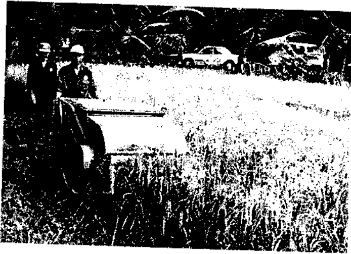
Hình 7 : Máy tuốt lúa trực tiếp trên bông.
